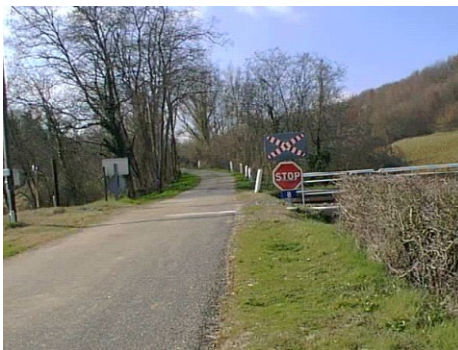
PN sans barrière avec STOP (cat2) (Source : Cerema)
