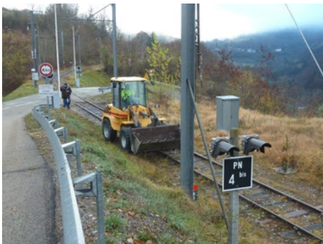
PN à franchissement conditionnel équipé de feux (source : Cerema)
