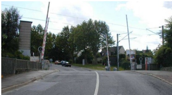
Profil en long accidenté (source : Cerema)
