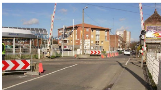
Chantier à proximité d'un PN (source : SNCF)
